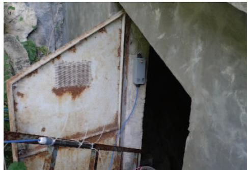
L'opera di "presa" del Fontanon di Timau ed il posizionamento della stazione di misura.
