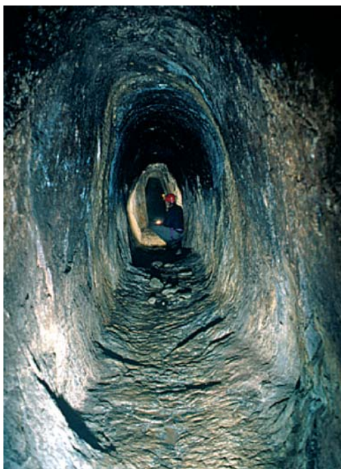
L'interno della galleria con la classica sezione ad ogiva.
