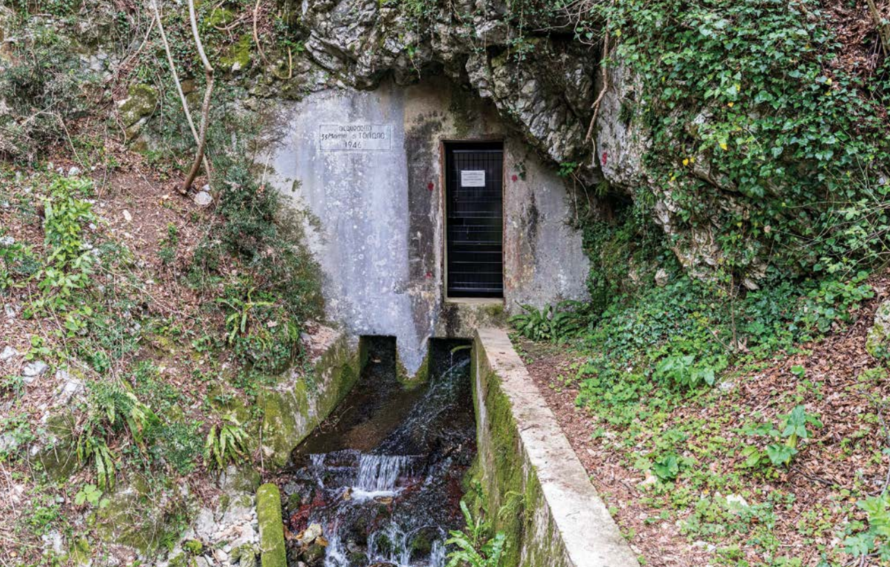
Fig. 1 - La presa di captazione della Fontanate di Torlano (foto A. D'Andrea).
