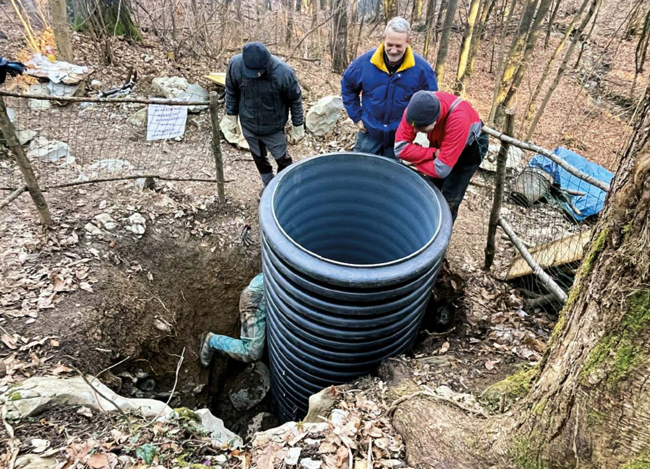
lalg: i lavori di messa in sicurezza del nuovo ingresso di San Giovanni d'Antro (foto F. Savoia).
