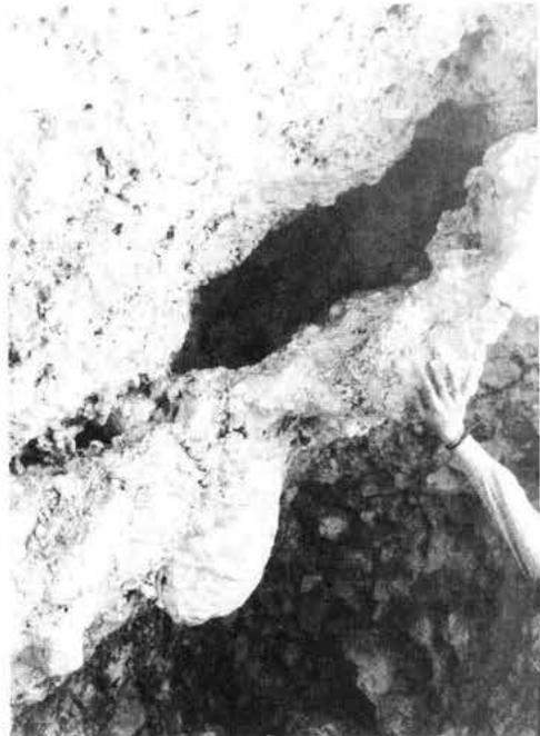
*Fig. 5 - Nicchia di disfacimento e sottostante cavità approfondita*
