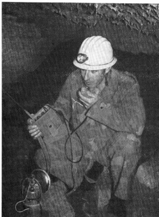
*Fig. 3 - Apparecchio PRC 119/6 - Rice-trasmissione con ricerca del punto di focalizzazione (vedi posizione inclinata dell'antenna).*
