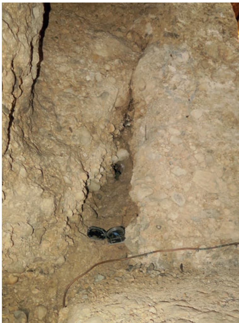
Fig. 8 - La frattura subverticale a bassa persistenza che interessa la parete in corrispondenza dei gradini nel vano-galleria NNE-SSW (corridoio E, punto a). Non è escluso che la frattura, inclinata di circa 30^\circ , sia stata allargata lateralmente per creare un piccolo vano.
